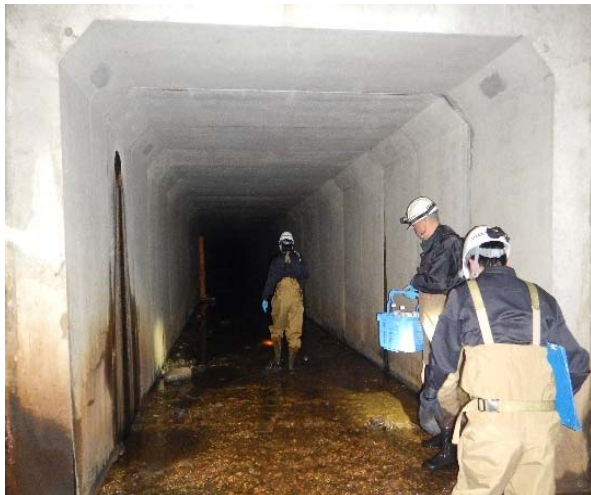
Fig.7 埋立処分場地下での現地調査
