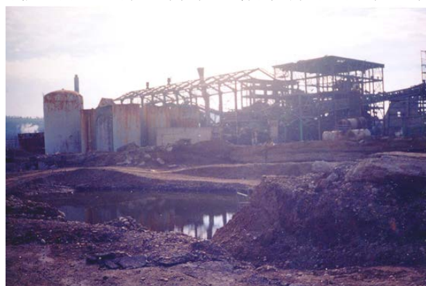
図1 硝酸アンモニウムで生じたクレーター [65m×45m、深さ7m、フランス・トゥルーズ、2001年9月、著者撮影(事故から6か月後)]
